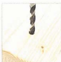
Pré-percer la vis d'accroche et la ferrure
