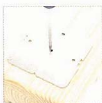
Marquer les perçages avec la platine de pointage
